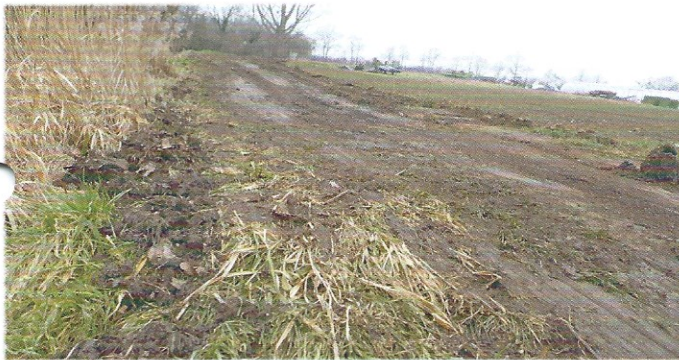
Der Weg entlang des Stechgrabens zwischen Eldinger und Ellerstadter Weg wurde mit Schotter befestigt. Zur weiteren Pflege wollen wir die Patenschaft übernehmen.
