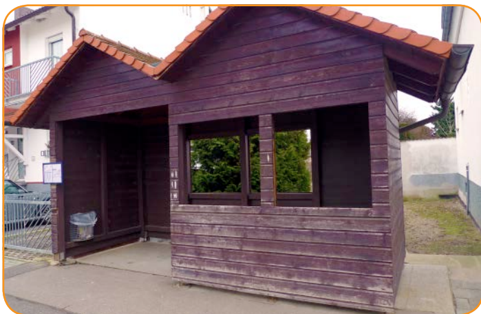
Bushalteshaus in der Meckenheimer Straße renovieren.
