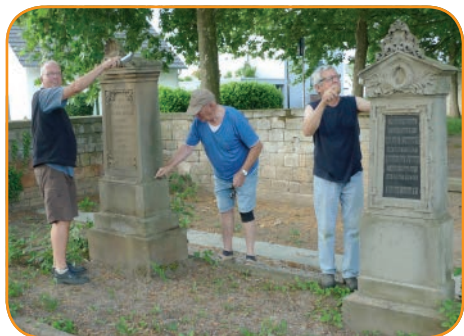
Historisches Grab grundsaniert.
