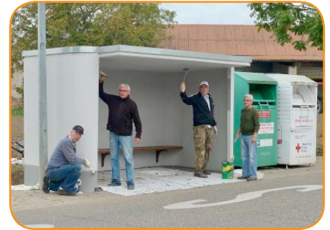
Bushaltehaus an der Assenheimer Straße grundrenoviert.
