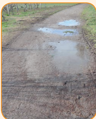
Schulweg südlich vom OT Rödersheim sanieren.
